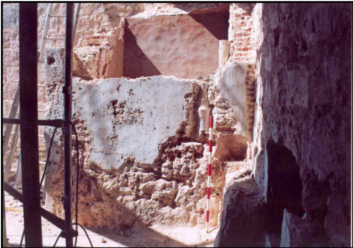
Fot.3. Vista de la cisterna situada a l'angle de l'habitació, durant el procés de desmuntatge.
